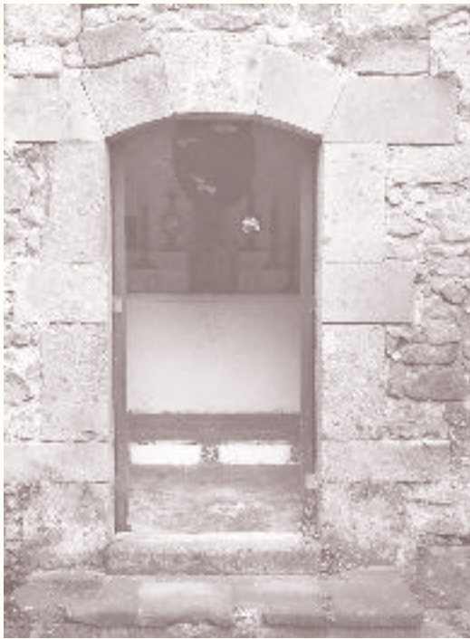
Arco escarzano, rancho de San Juan Totoltepec. Fotografía: Xavier Cortés Rocha, 2017.
